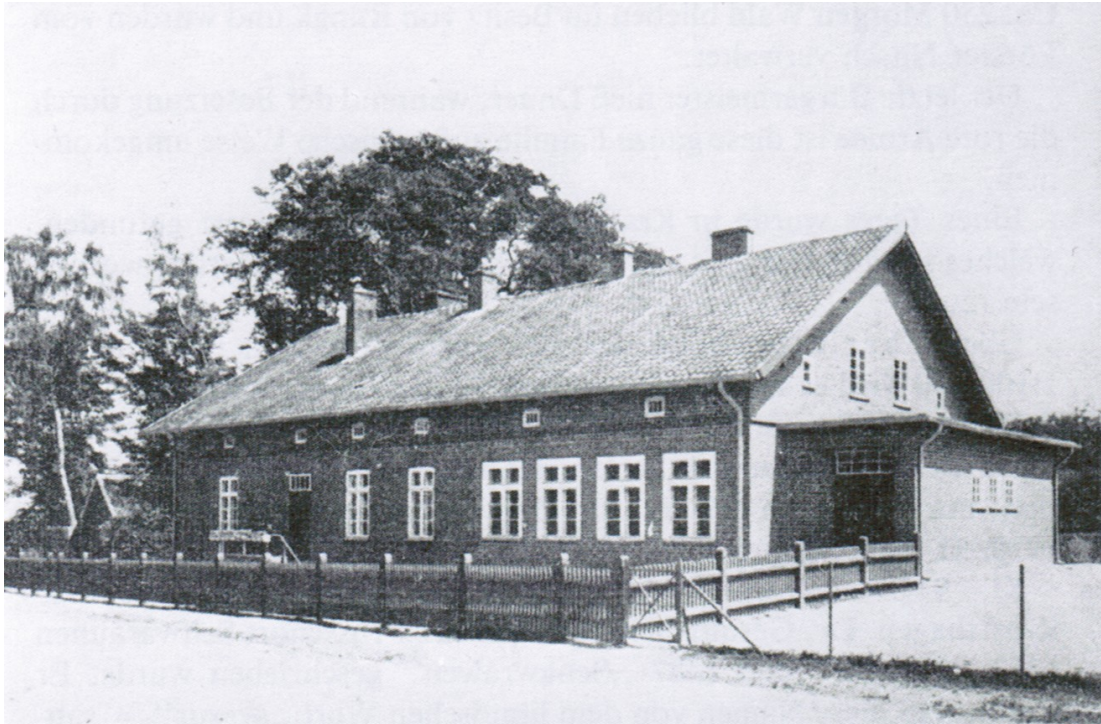
Oben: Schulgebäude der zweiklassigen Volksschule in Kraftshagen.
