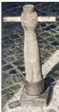
Hölzerner Stampfer mit gusseisernem Fuß (Werkzeug zum Verlegen von Kopfstein-Pflaster im früheren Friedländer-Tor-Durchgang).
